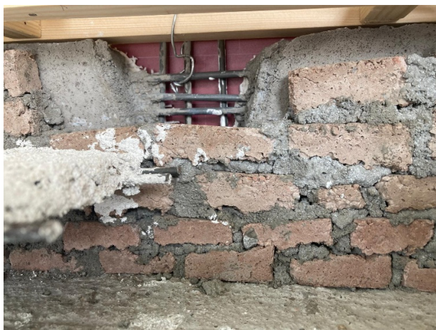
Figura 4. Detalii realizare zidărie
